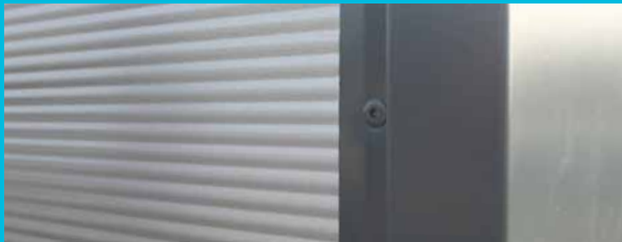
Hoekafwerking en aansluiting op paneel
